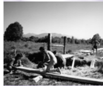
Construction du sentier
