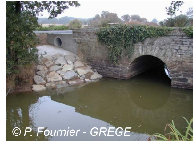
Mise en place d'une buse sèche (PNR de Brière)
