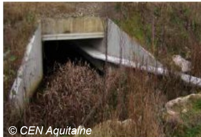
Mise en place d'un encorbellement (DRE Midi- Pyrénées – GREGE)
