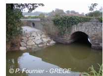
Mise en place d'une buse sèche (PNR de Brière)
