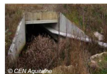
Mise en place d'un encorbellement (DRE Mid- Pyrénées - GREGE)
