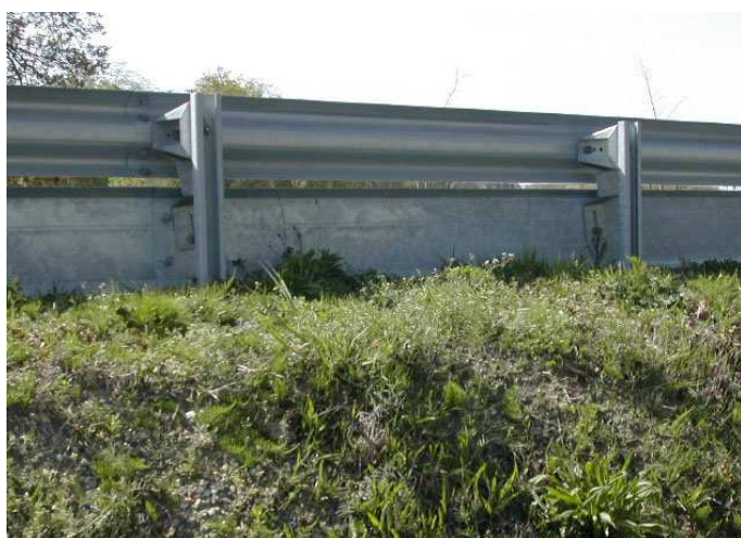
Glissière moto raccordée de façon étanche au sol (Photo Pascal Fournier)
