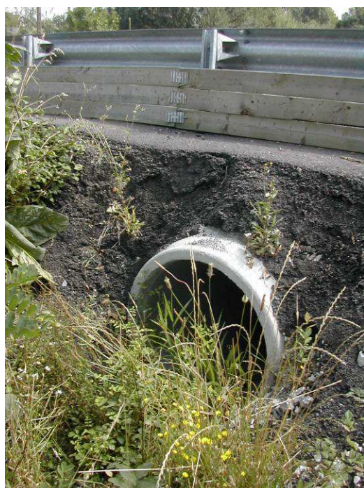
Buse sèche équipé d'une palissade installée à l'arrière d'une glissière de sécurité (Photo : Pascal Fournier)
