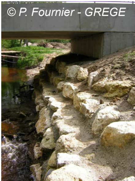
Mise en place de banquettes en enrochement (ONYX – GREGE)
