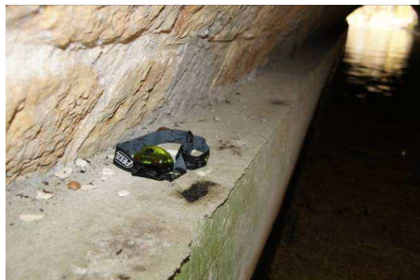
Epreintes de Loutre sur un renfort de pied d'ouvrage (Photo : Pascal Fournier)
