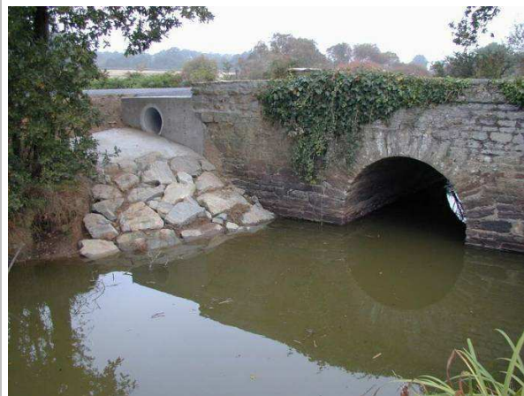
Buse sèche installée en Brière (Photo : Xavier Moyon).
