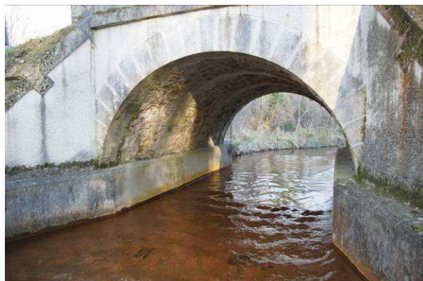
Ouvrage hydraulique équipé d'un renfort bétonné de pied d'ouvrage (Photo : Pascal Fournier)
