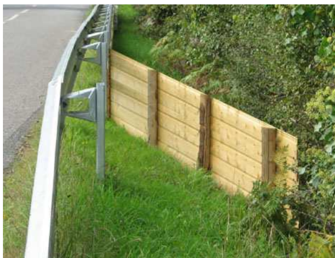
Palissade sur piquet bois (Photo : Xavier Moyon).
