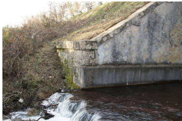
Exemple de banquettes non utilisables à réhabiliter à moindre frais pour assurer le cheminement des petits carnivores (Photos : Pascal Fournier)
