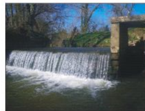
Vue depuis l'aval de l'obstacle. On peut voir la chute au déversoir et le canalet de décharge et de dégravolement fermé en tête, par des madriers.
