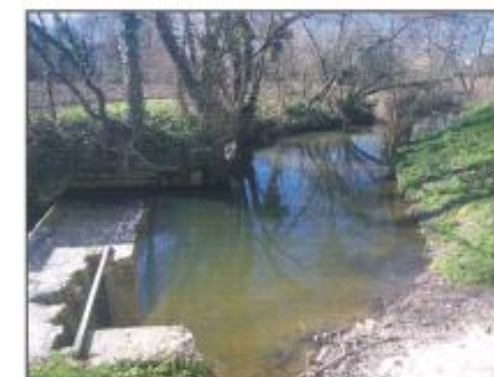
Vue de la retenue ensablée. On aperçoit en premier plan en rive gauche, l'ancienne prise d'eau comblée du moulin. On aperçoit également la prise d'eau du canalet de décharge.
