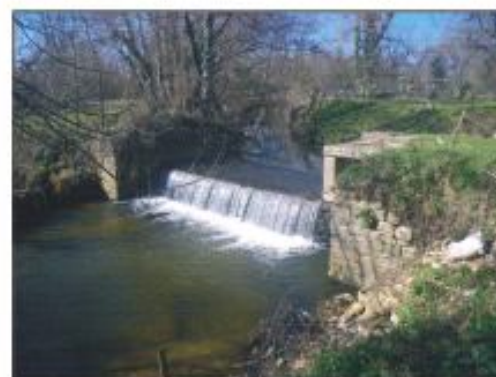
Vue générale de l'obstacle. On peut voir le seuil déversoir en rive droite et le canalet de décharge et de dégravolement en rive gauche.
