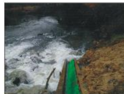
Rampe à anguilles à double pendage (brosses Fish Pass)
